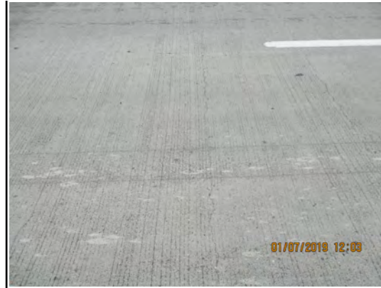
Deck Transverse Cracks Typ. EBL
