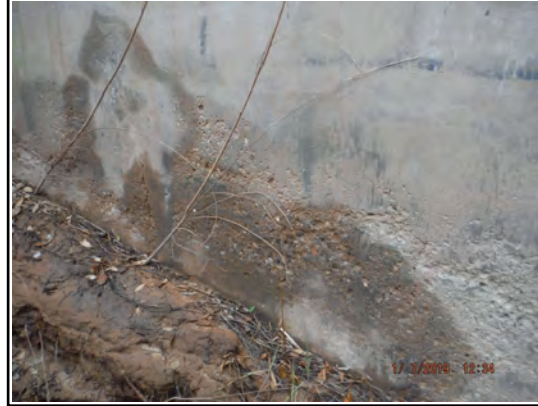
Wingwall N.E. Scaling
