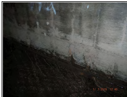
N. Cell Spalling W. End
